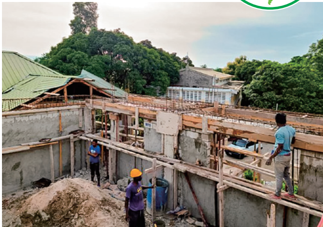
ハイチで建設中の校舎
